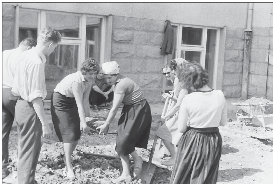
Porządkowanie terenu WSP w czasie budowy gmachu głównego (rok 1958). Na zdjęciu – studenci matematyki (rocznik 1957-61).
