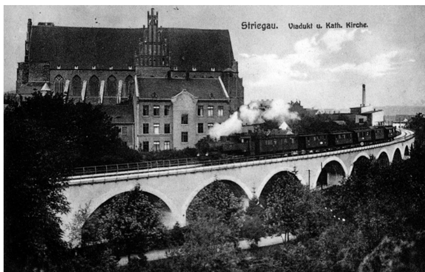
Wiadukt kolejowy (w głębi kościół katolicki)
