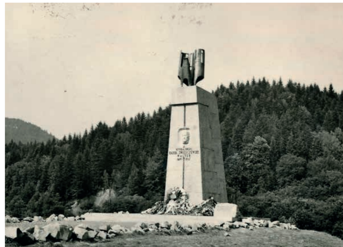
Pomnik gen. Karola Świerczewskiego pod Baligrodem, autorstwa Franciszka Strynkiewicza – rektora warszawskiej Akademii Sztuk Pięknych, zniszczony w ramach dekomunizacji w 2018 roku
