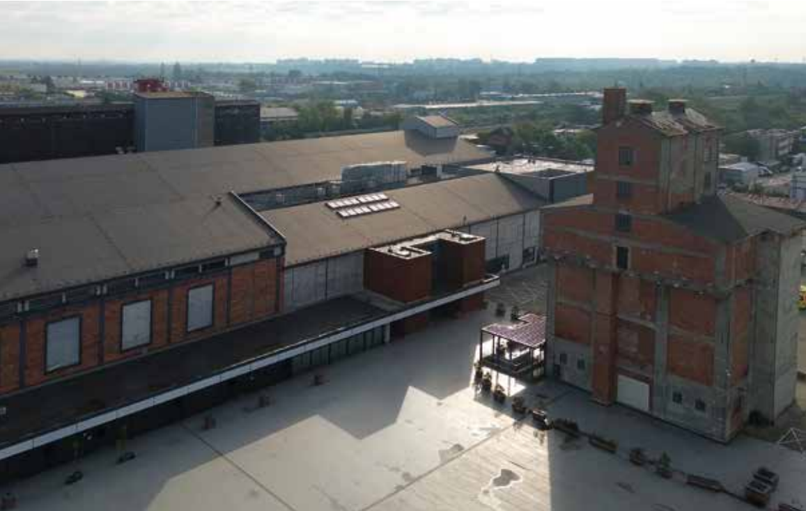
W obiekcie o powierzchni 26 tys. m. kw., z czego ponad 20 tys. to przestrzeń użytkowa, znajdują się trzy kondygnacje
