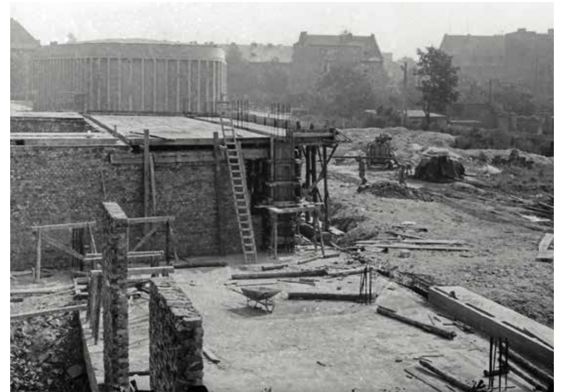
Rok 1967. Budowa gmachu, w którym dziś mieści się Teatr Dramatyczny i Galeria Sztuki Współczesnej
