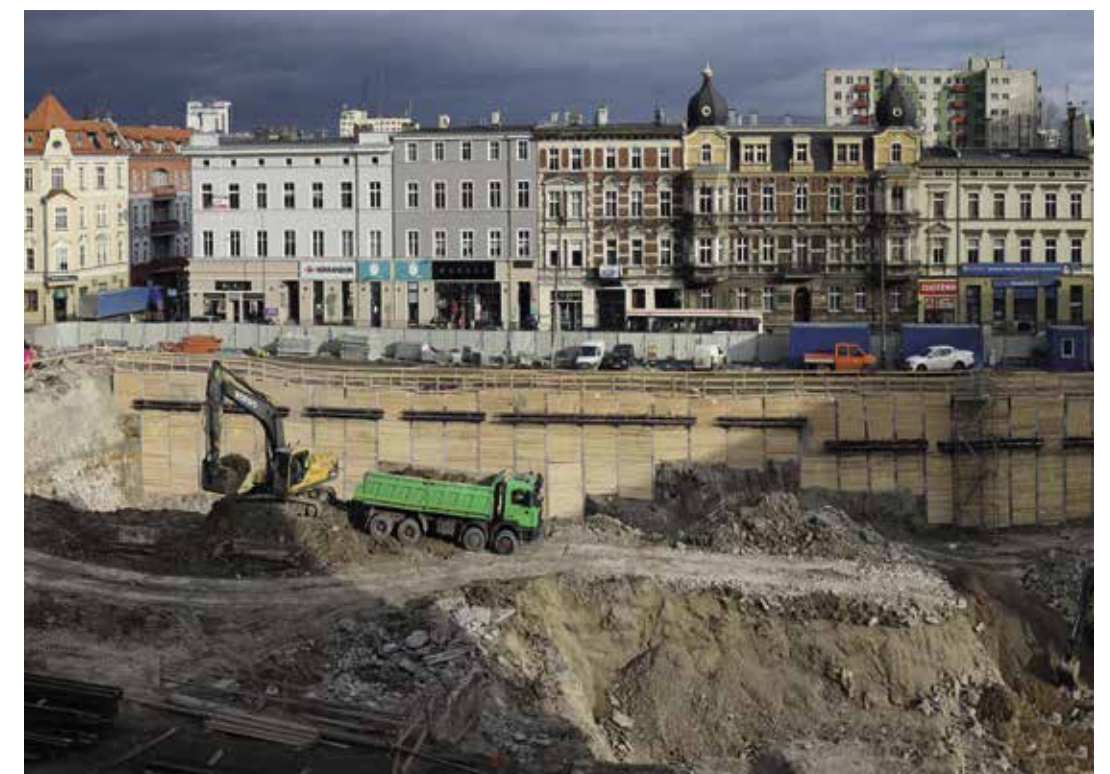
Budowa podziemnego parkingu na pl. Kopernika
